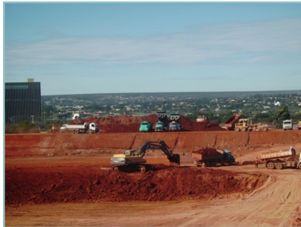
Foto 12 – Terraplenagem – Corte e Aterro
