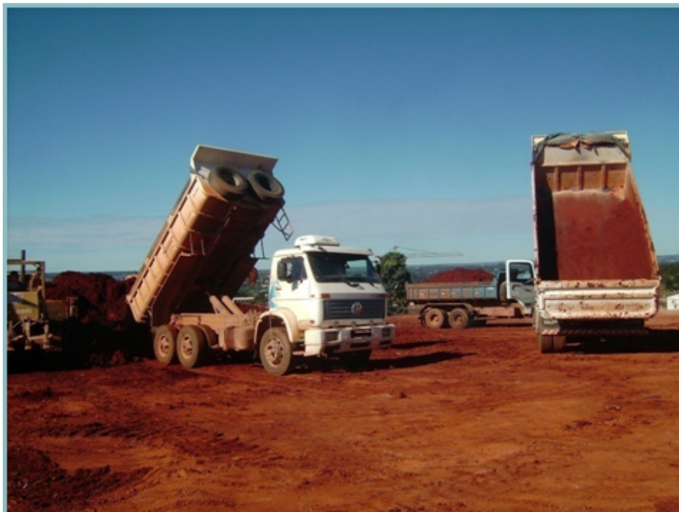
Foto 5 – Terraplenagem – Transporte, lançamento e espalhamento de material escavado
