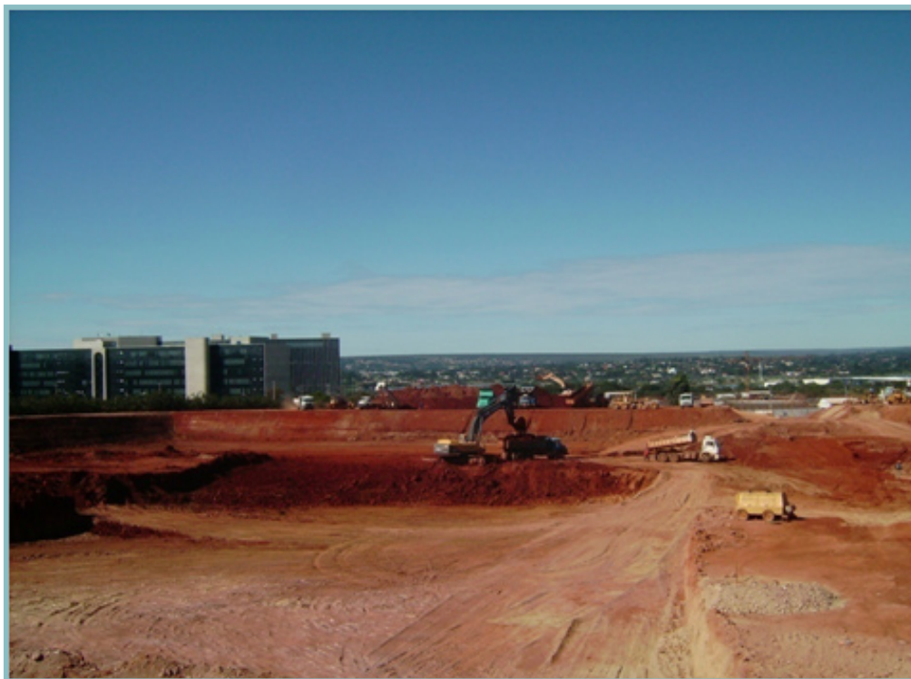
Foto 11 – Terraplenagem – Corte e Aterro
