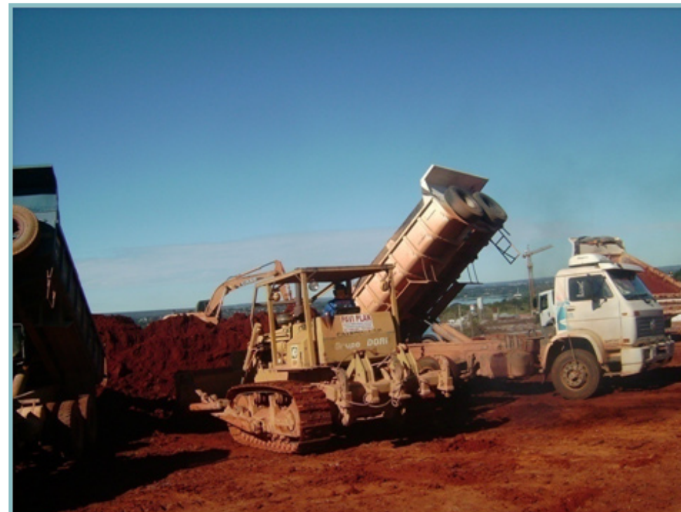
Foto 6 – Terraplenagem – Transporte, lançamento e espalhamento de material escavado
